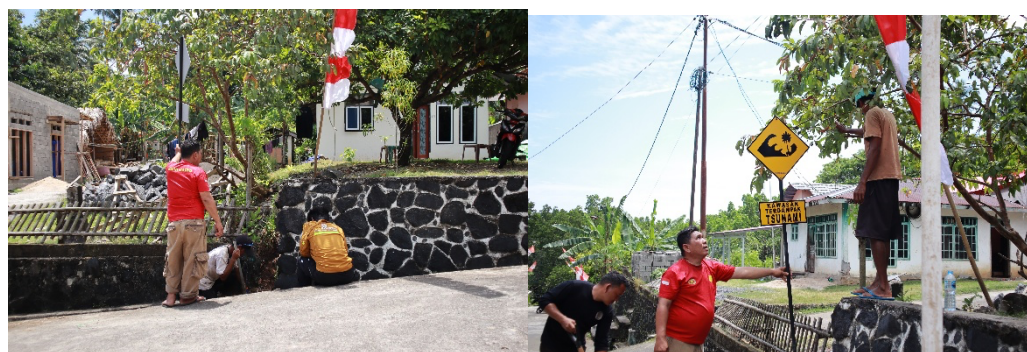
Gambar 9. Pemasangan Rambu Jalur Evakuasi
