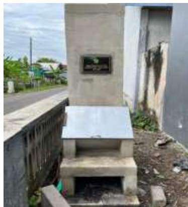
Gambar 3 Realisasi Tungku Pembakaran Sampah Minim Asap
